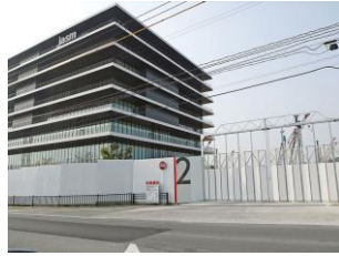
菊陽町ではJASMの第2工場の建設が進む
